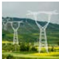
水利、电力建设
