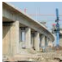
道路、桥梁施工
