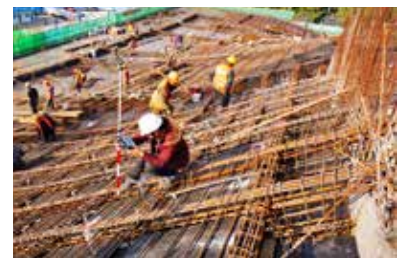
施工放样与检测
