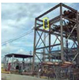
1套拓普康 Delta 系统 +GT1001 测量机器人可完 成 施工改建监测
